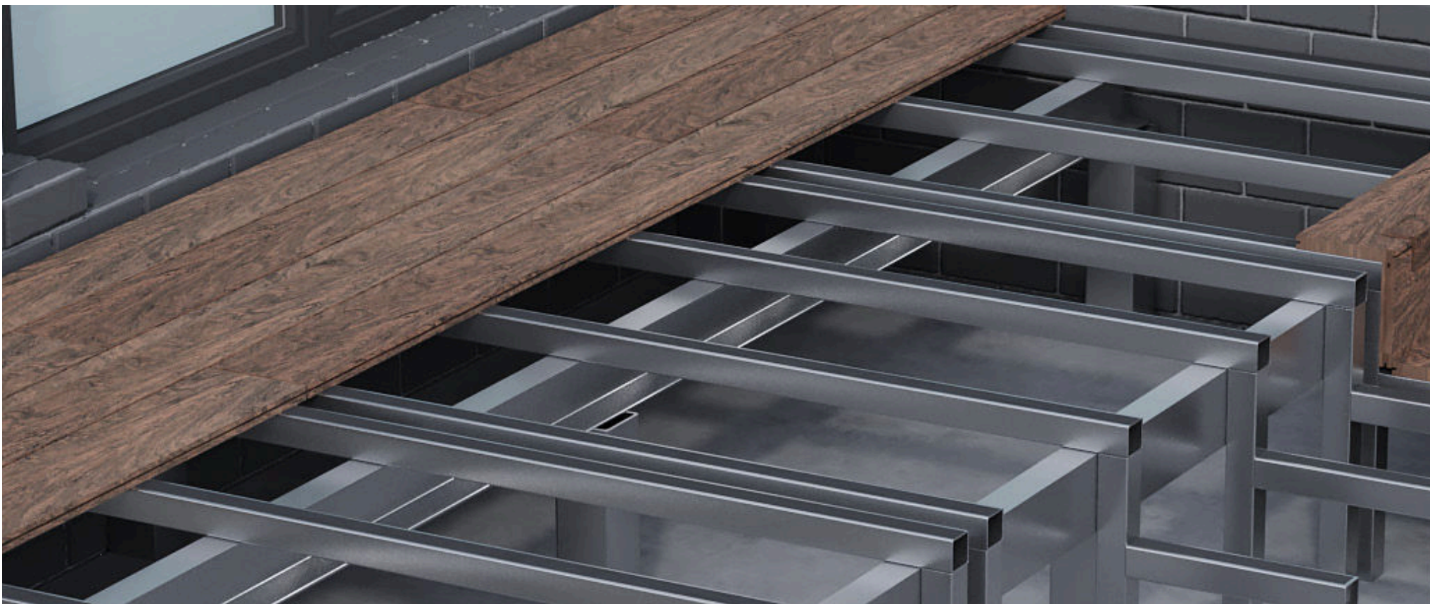
Montaż ramy metalowej.
